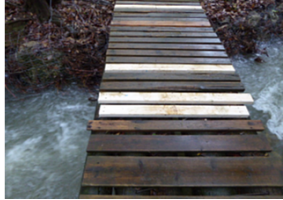
橋桁腐朽 一部交換
