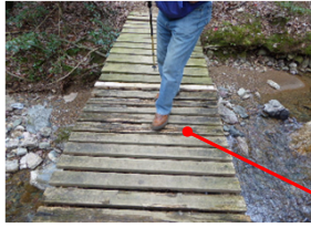
橋桁腐朽 一部交換
