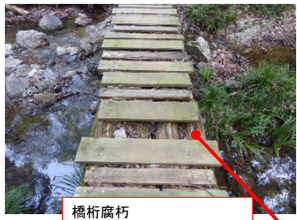
橋桁腐朽 一部交換 ・のこぎり ・インパクト電気ドリル
