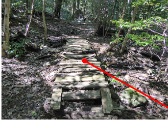
橋桁腐朽 一部交換 ・のこぎり ・インパクト電気ドリル
