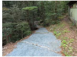
2021/11/6.~12/1 ユンボで拡幅、クリ碎石投入、土か
