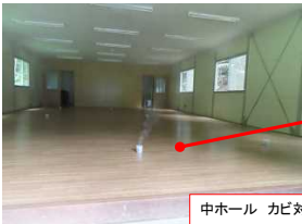
中ホール カビ対策 ・浴室用燻蒸実施 (2022/6/11)
