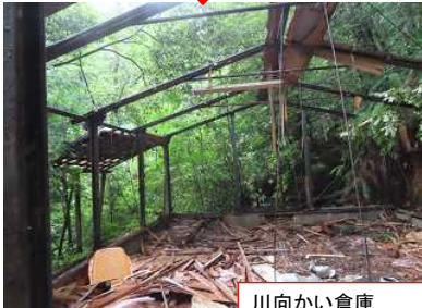
川向かい倉庫 2022/7/1解体開始
