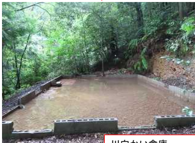
川向かい倉庫 2022/7/8 解体 整理完了 ※床が 土で固められており 水はけが悪い ↓ ※出口側のブロックを 少なく とも 一部 取り外し 水道を付け る必要あり
