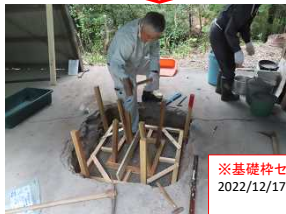
※底 灰、砂、土除去 2022/12/17
