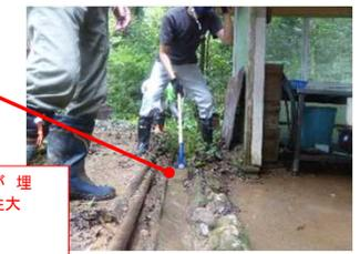
たき火場、水道ガス台周り 排水溝が埋まっており 土砂が 流れ込み可能性大
