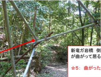
新電ガ岩橋 倒木により 一部単管が曲がって居る
